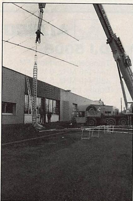
Remplacement d'une des deux 7 éléments par la FB-53 de Fritzel (au sol).
